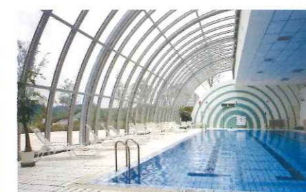
温水プールのスチール上屋
