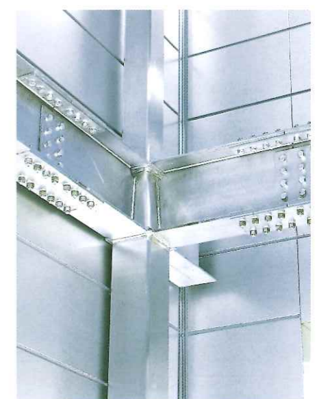
ステンレス製柱・梁
