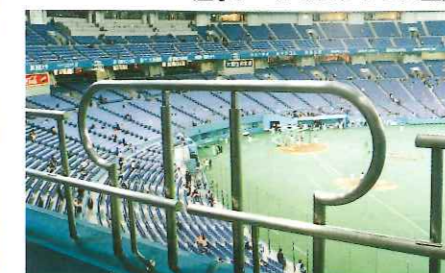
手すり(京セラドーム大阪)
